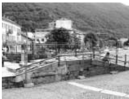
Un momento dei lavori per l'abbattimento delle barriere
